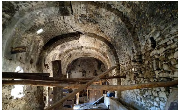
13. Οι καμάρες / Vaults
