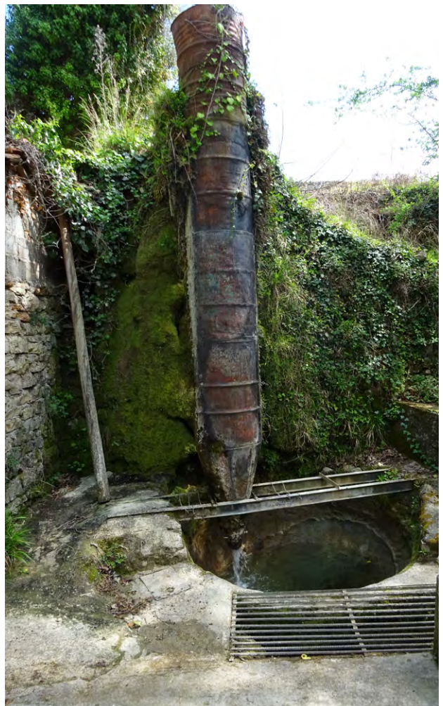
5. Η νεροτριβή νερόμυλου στην Αγία Σοφία / The fulling tub of the water mill in Haghia Sophia
