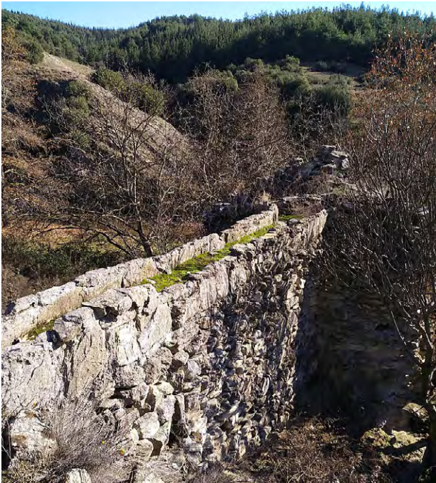
14. Το μυλαύλακο του λαδόμυλου / Flume
